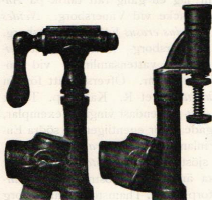
Fig. 1. Till vänster Bordeaux -, till höger enkel Vermorel -spridare, båda fästa vid mellanstycke försedt med stånghållare. (Orig.).
