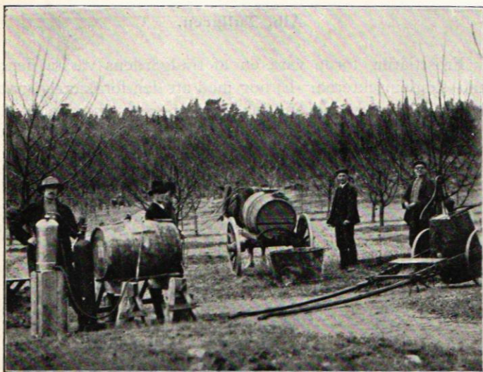
Fig. 7. Depot vid besprutningarna i Gripsholms slottsträdgård våren 1910. Från v. t. h.: Bill -spruta kopplad till kolsyrebehållare för påfyllning, fat med vattenlöslig karbolineum ( Defensolat ), vattenliggare och kopparkittel för vätskans blandning, Simplex -spruta (Orig.)
